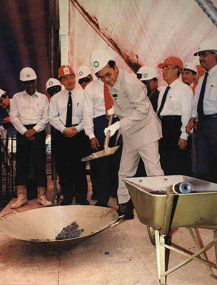
YAB Datuk Seri Dr. Mahathir Mohamad, ketika perasmian upacara Penuangan Konkrit (Concrete Pour) untuk Menara Dua, Menara Kembar PETRONAS pada 19 Februari 1994
